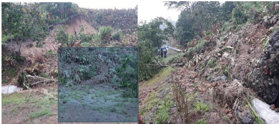
Este deslizamiento provocó múltiples deformaciones de esta tubería y el desmontaje de la junta de expansión más cercana al deslizamiento, tema que se observa en la siguiente imagen: .....
