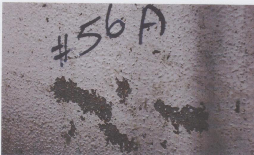
Foto #4. Presencia de ampollas debajo del recubrimiento y corroborado mediante raspado del recubrimiento al dejar descubierto la oxidación en tramo de los tubos #56 al tubo #58, PH Birris, Jasec, Cervantes, Cartago, 23 marzo 2015.
