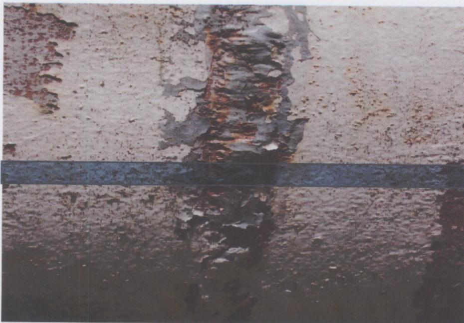
Foto #2. Estado de afectación del sistema de recubrimiento y estado corrosivo del cordón de soldadura y cuerpo del tubo #37, PH Birris, Jasec, Cervantes, Cartago, 23 marzo 2015.
