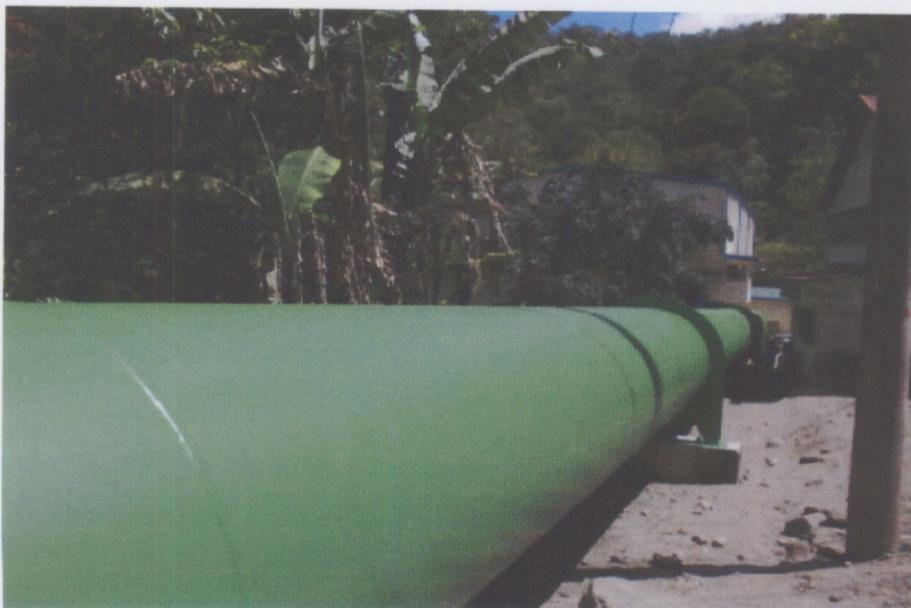
**Foto #1 Tubos del #1 al #4 recubiertos con sistema de recubrimiento curado por humedad de MCU, PH Birris, JASEC, Cervantes, Cartago, 6 marzo 2015.**
